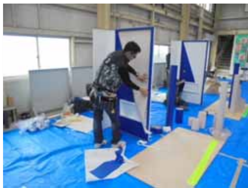
* 内装仕上げ施工職種 *
