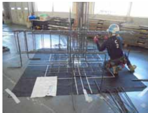
* 鉄筋施工職種 *
