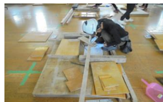
型枠施工 (随時3級)
