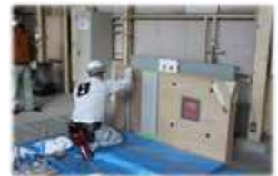
樹脂接着剤注入施工 (樹脂接着剤注入工事作業)
