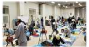
配管 (建築配管作業)
