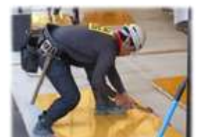
型枠施工 (型枠工事作業)
