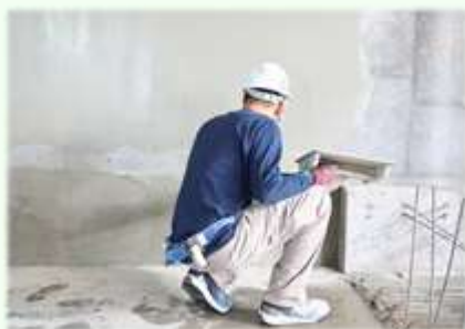
壁の仕上げ塗り
