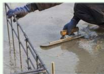
土間コンクリート押さえの左官工事
