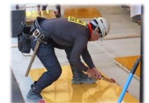
型枠施工 (型枠工事作業)
