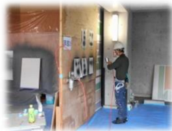
塗装 (建築塗装作業)
