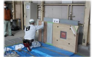
樹脂接着剤注入施工 (樹脂接着剤注入工事作業)
