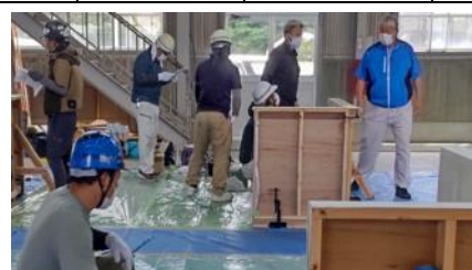
* 県防水工事業協同組合 防水施工 *
