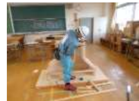
型枠工事 (随時2級)
