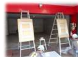
基礎級 防水施工
