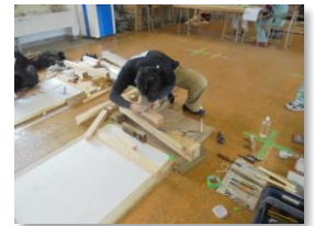
建築大工 (大工工事作業)
