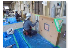
樹脂接着剤注入施工 (樹脂接着剤注入工事作業)
