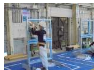
防水施工 (随時3級)
