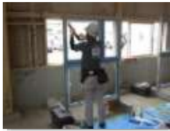
防水施工（随時３級）
